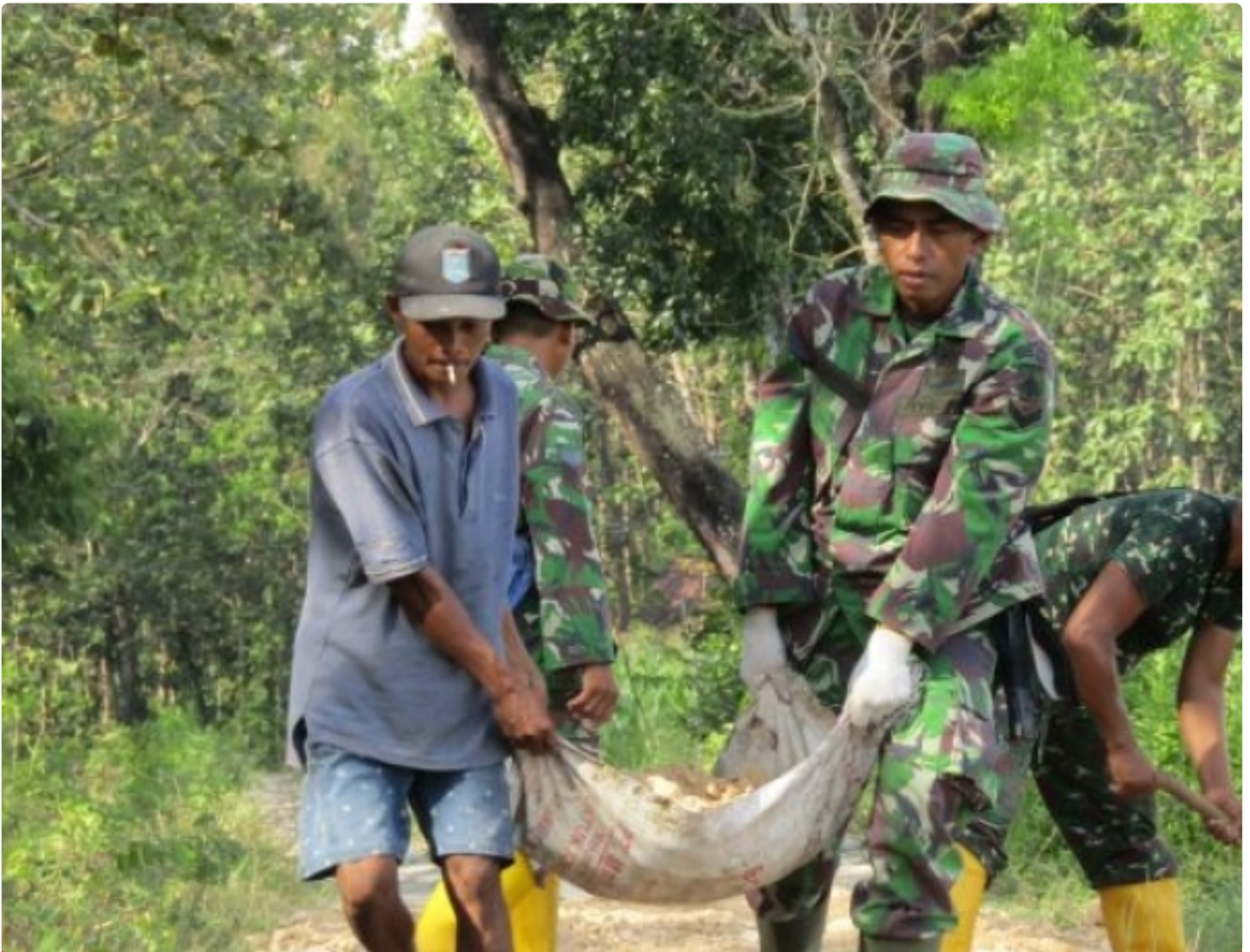
Satgas TMMMD bersama dengan warga dalam pembangunan ruas jalan di lokasi TMMMD reg ke-113 di desa Pengkoljagong
