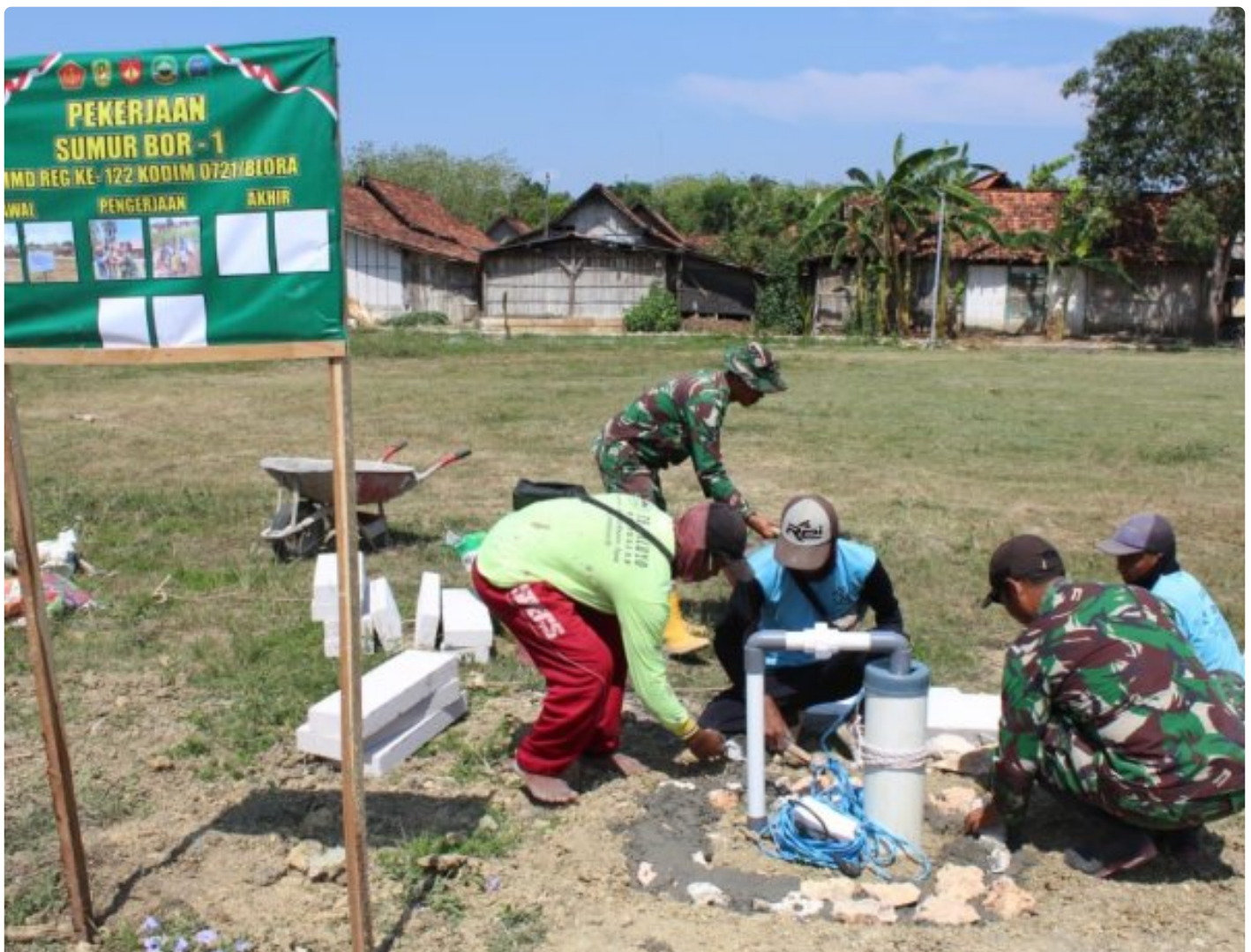
Foto: Anggota Satuan Tugas TNI Manunggal Membangun Desa (TMMMD) 122 Kodim 0721/Blora berkolaborasi dengan warga Desa Sidomulyo untuk melanjutkan pembuatan batu hebel pelindung pipa sumur bor, pada Minggu, 20 Oktober 2024.
