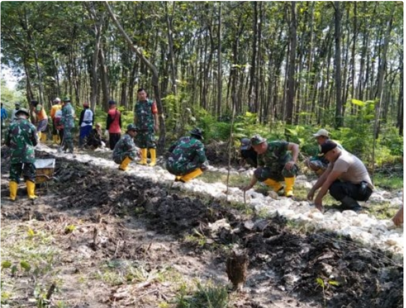
Satgas TMMD bersama warga terus berjibaku dengan drum truk menurunkan material batu di lokasi TMMD
